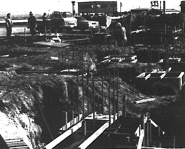
消防署分遣所建設工事 来年3月からスタートする北部地域の分遣所の建設工事が始まりました。完成後は、北部地域を中心に消防・防災活動に当たります
