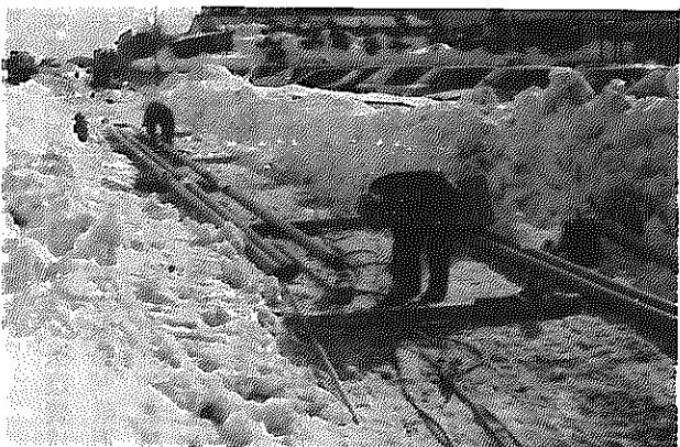
都市下水路東幹線排水路工事
