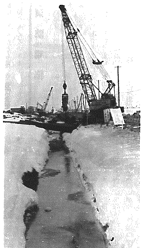
地盤沈下対策事業で行われた北田中下江排水路工事
