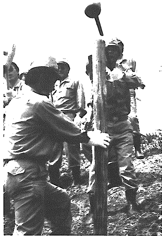
打つ 堤防の斜面にくいを打ち、築直し工法にいとむ
