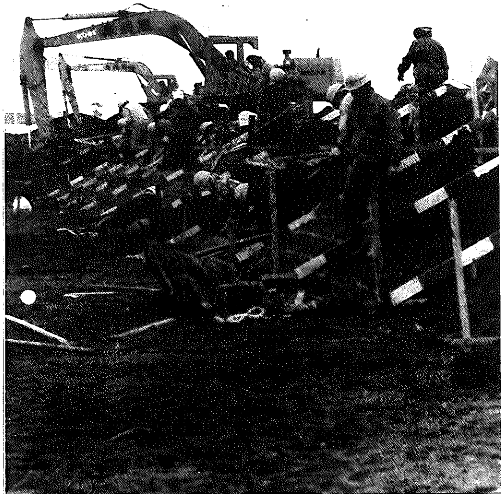
信濃川沿い庄瀬地内の堤防低部対策工事
