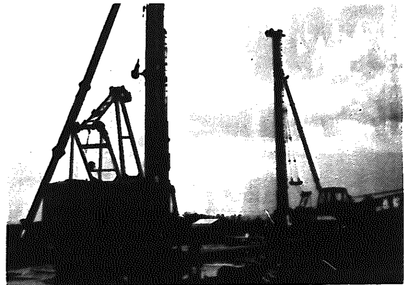
昭和58年4月開校をめざして建設工事が始まった小林小学校
