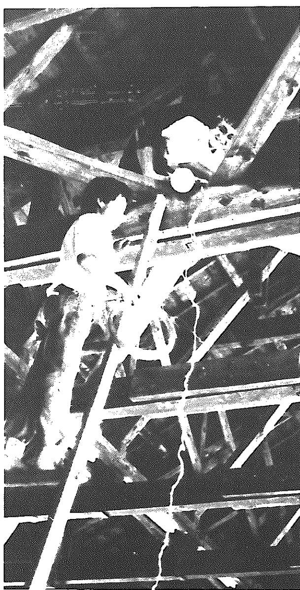
▲体育館の天井に登ってステージ照明作り。このステージ照明は、あき缶の中に探電球を入れたもの
