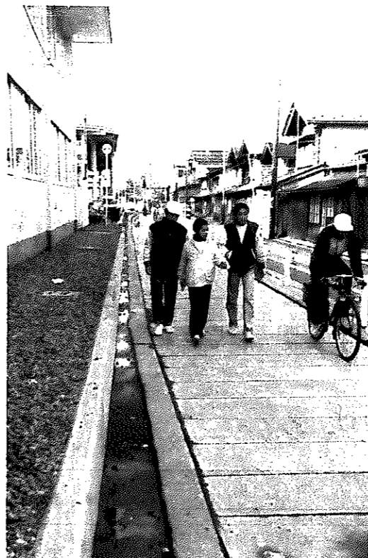
完成した都市下水路は、市民が安心して通れる歩道に
