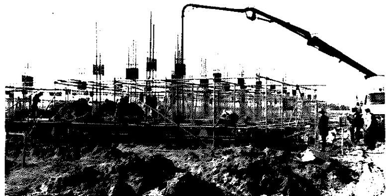
つち音高く、着々と進む建設工事
