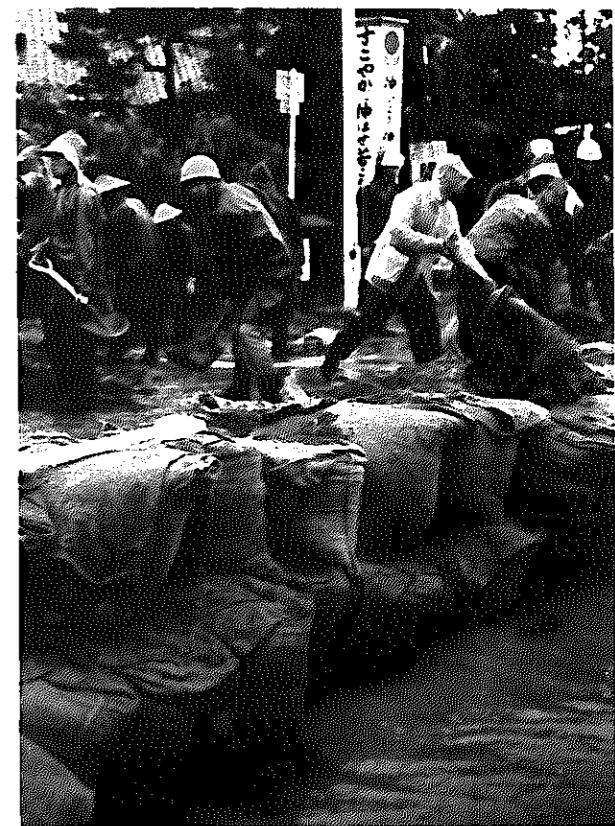
▲堤防と水位が同じに——土のうを積んで必死に防ぐ(大郷橋十字路)
