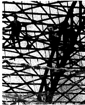
炎天下、地上15メートルの高さで 鉄骨組み(体育館屋根)。
