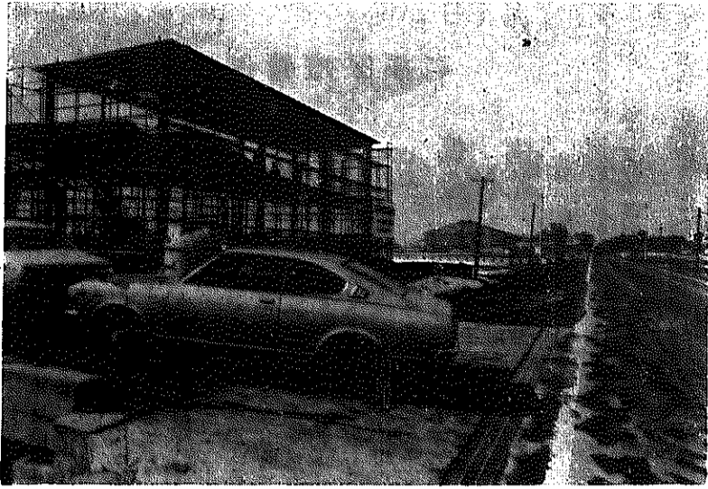
▲ 工業地に指定された和泉地区。県道白根・安田線を中心に、その団地化が進められます。
