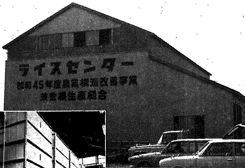
完成した茨會根のライスセンター
