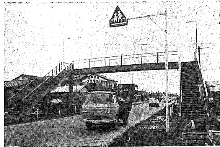
中央保育園臨に歩道橋 歩道橋の架設が望まれていた、中央保育園の国道に歩道橋がお目見えしました。市内で二つ目のこの歩道橋は、三月二十九日に渡橋式を行ないます。
