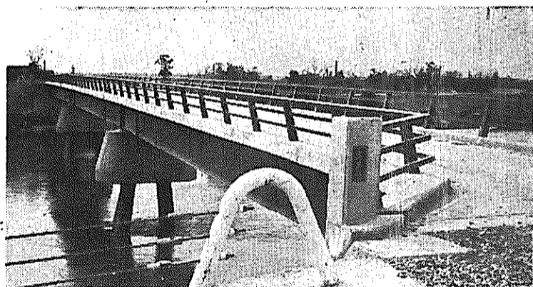
災害復旧事業として九八・七%の高率国庫補助をうけて、三十九年から二カ年の継続事業で工事が進められ、二月に完成した高井橋。萱場橋、松橋もこれと同じスタイルでしゅん工。
