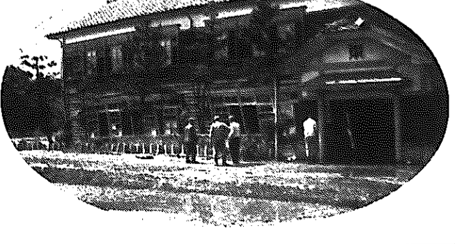
校舎は傾き、グラウンドは地下水が吹き上げて、どろ沼と化した旧根岸中学校(昨年6月16日に写す)
