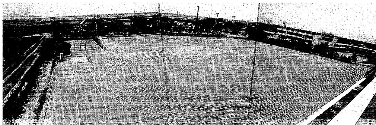
▲村単独事業・味方中学校グランド整備工事
