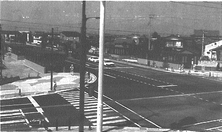
交差点に設けられた地下横断歩道
