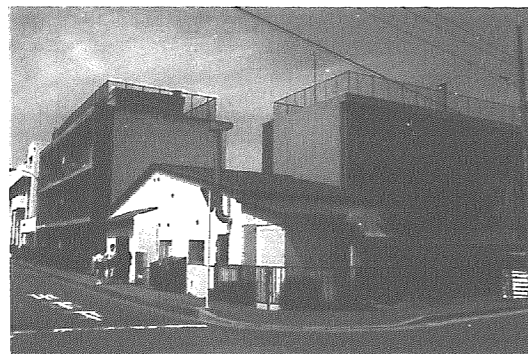
◀ 中学校東校舎(左側)と北校舎(右側)
