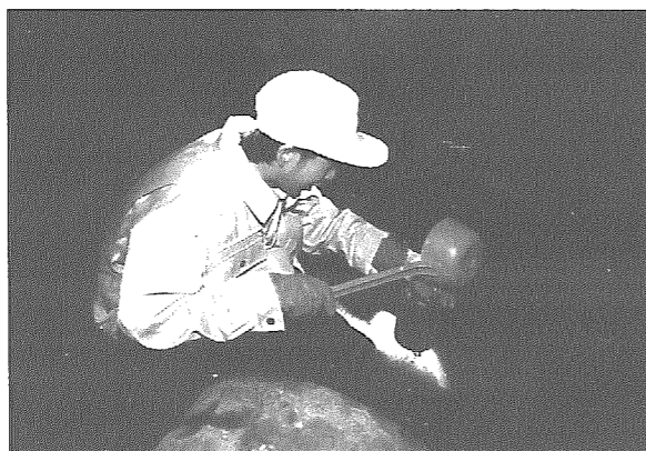
▲マンホールの下の下水道に降りて、水質調査
