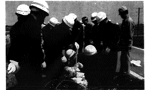
水防工法作業を行う消防団員の方々
