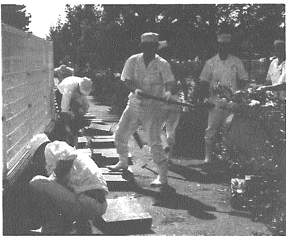
椋塚田牛乳新工場脇の下水溝清掃作業
