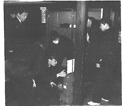
本館での消火器点検
