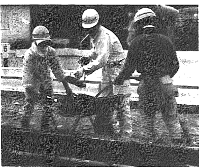
村民プール改修
