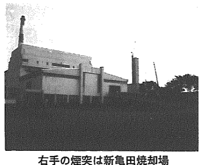
右手の煙突は新亀田焼却場
