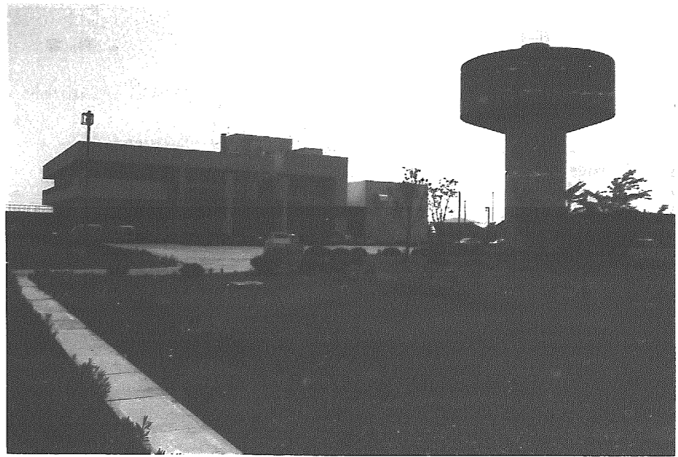
阿賀野川浄水場
