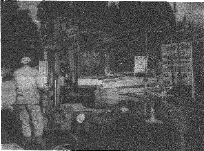
沢海・大栄寺脇の下水道工事現場
