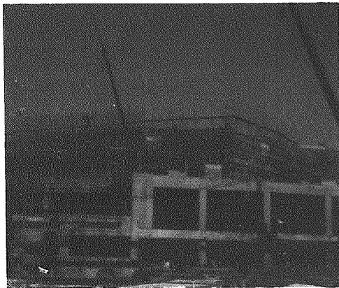
順調に進む総合体育館工事
