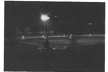
中学校に新設された夜間照明施設
