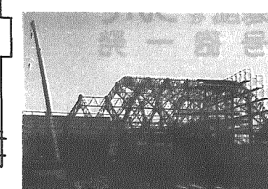
順調に進む中学校新体育館
