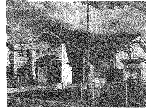
移転新築された横越駐在所
