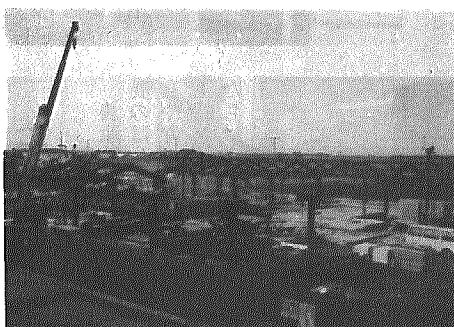
順調に進む福祉センター建設工事
