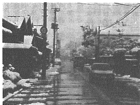
待望の消雪パイプが完成
