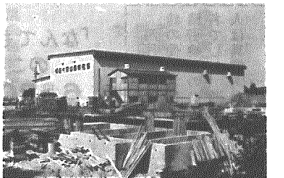
工事が進められる建設現場
