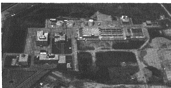
新潟市(東部)・亀田町・横越村の下水を処理する 新潟浄化センター
