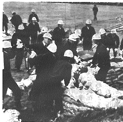
横越村消防団による月の輪工法
