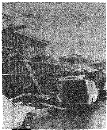
急ピッチで進む展示住宅工事
