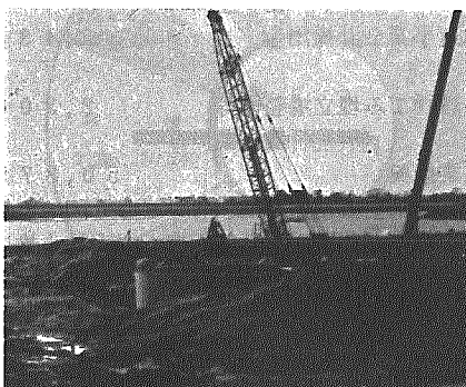
すでに始めている橋脚工事 (対岸は小杉)
