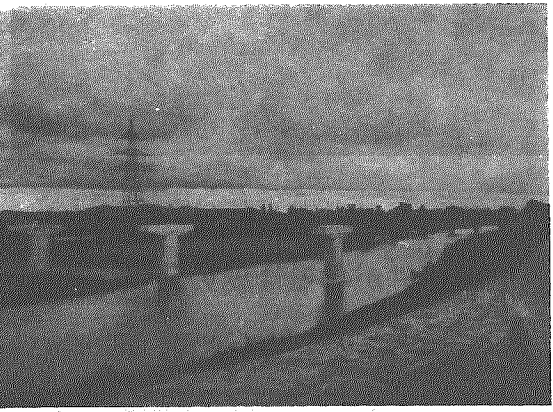
橋脚ができ上部工をまつ小阿賀橋
