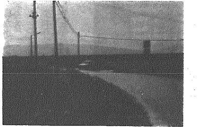
大型車が曲れるように(小杉入口)
