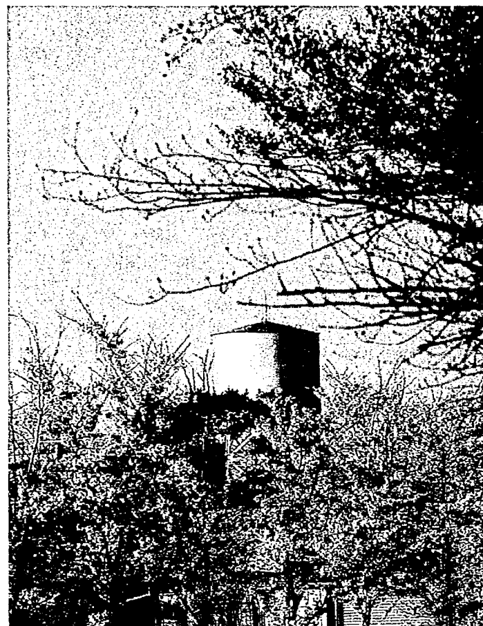
候補地の一つ亀田浄水場内 『水道タンク』
