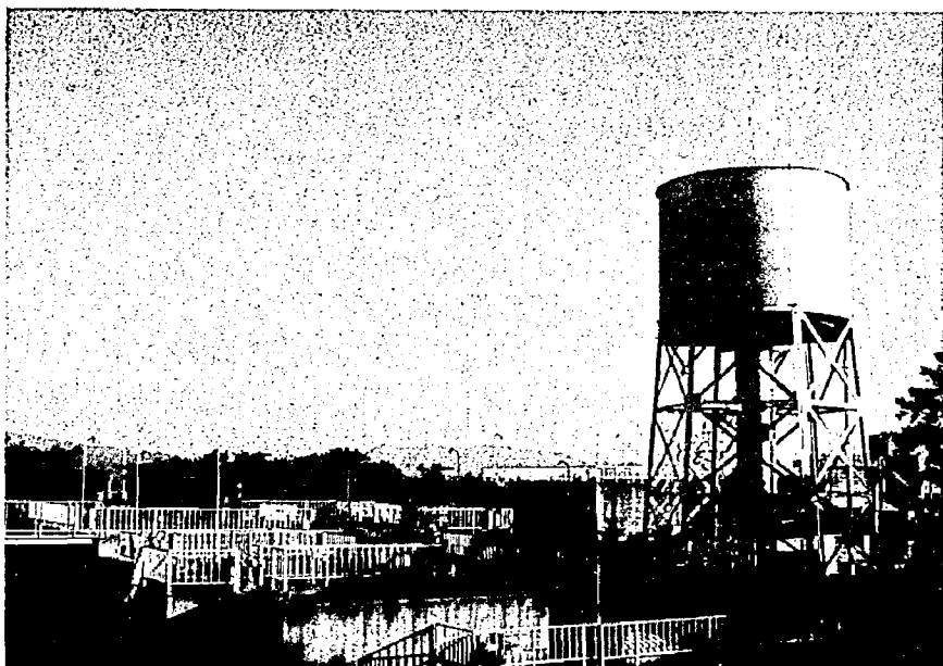
▲亀田町水道局 向山浄水場
