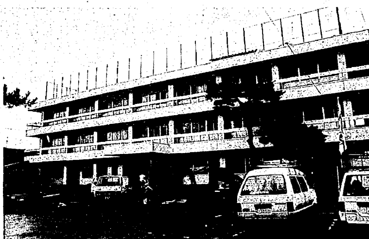
改修工事が進む土地改良区跡地
