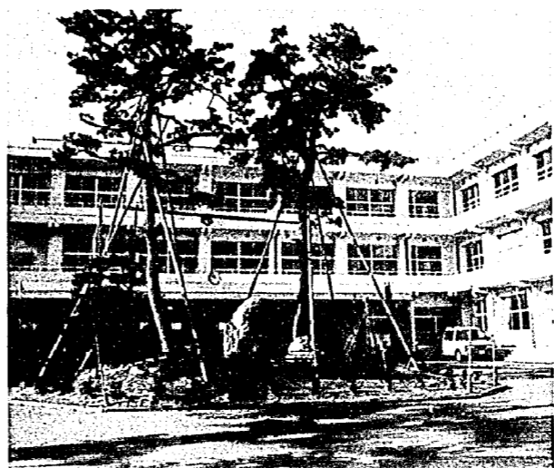
増築された亀田西小学校
