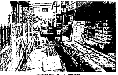
枝線管きよ工事
