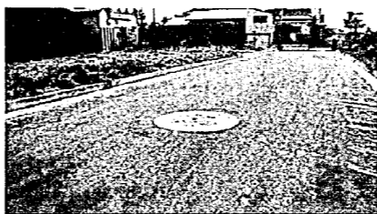
管きよ工事完了後
