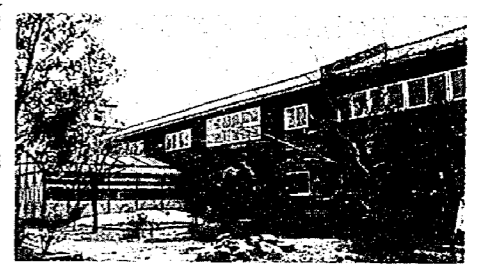
亀田中学校木造校舎増改築
