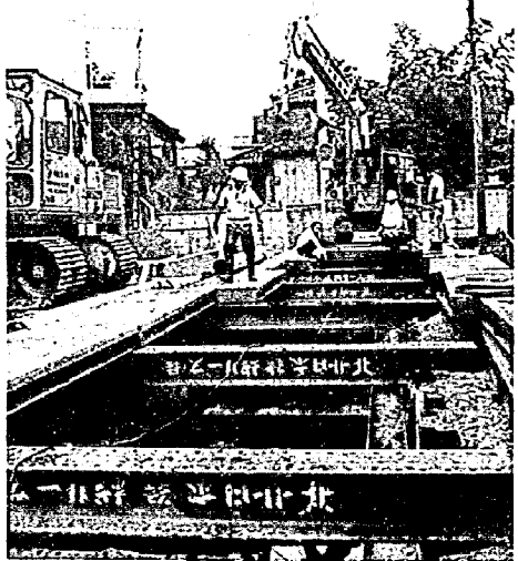
幹線管きよ工事
