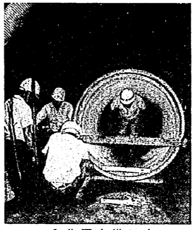
公共下水道工事
