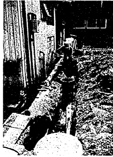
排水設備等の工事
