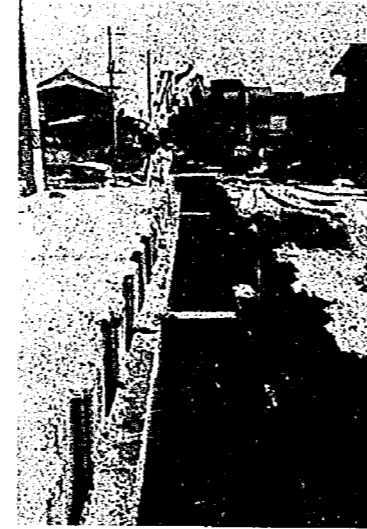
枝線管きよ工事
