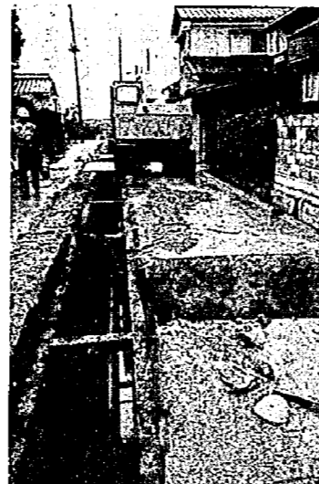
枝線管きょう工事
