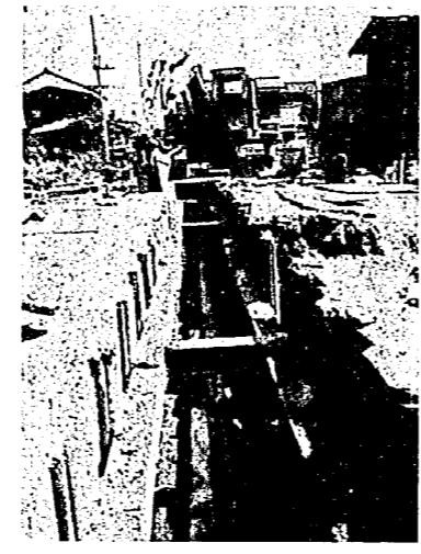
枝線管きょ工事
