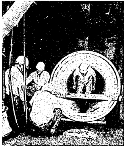
流域下水道新潟幹線に接続
